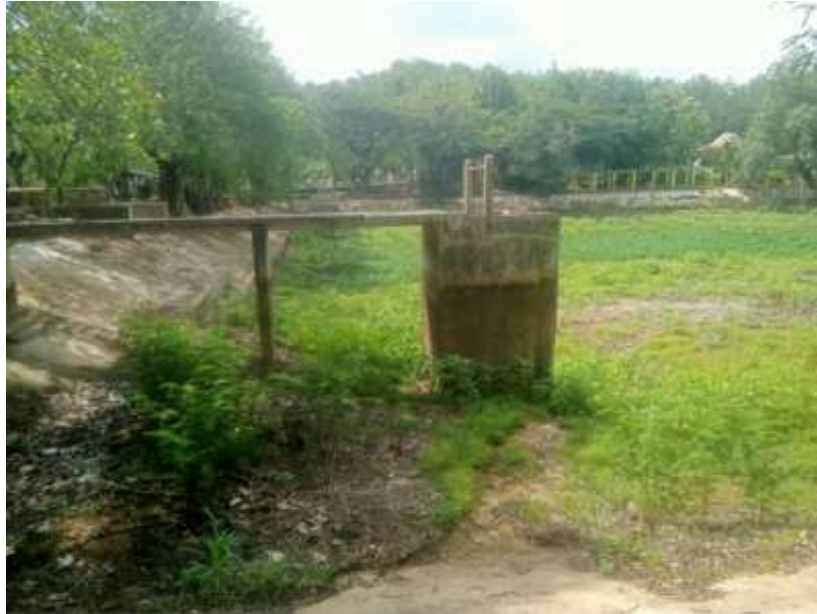
Gambar 4. Kondisi dasar telaga yang mengering dengan struktur bendung/pintu air Sumber: iNews Pringsewu. (2024, 20 November).
