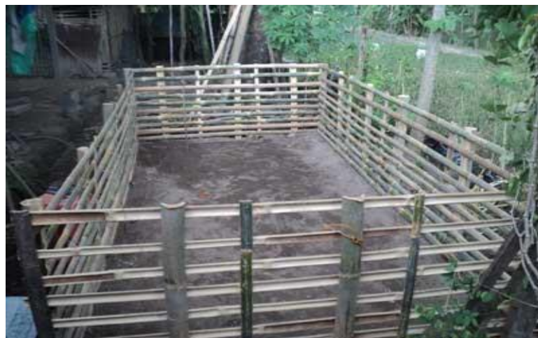
Gambar 3. Pemasangan pagar dinding bak dengan patok bambu
