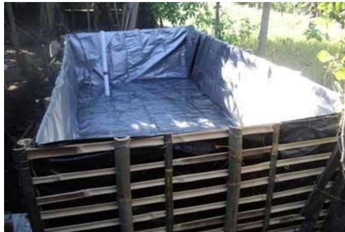
Gambar 5. Bak terpal dengan kerangka bambu
