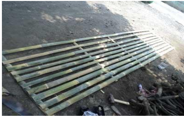
Gambar 2. Proses Pembuatan Pagar Bambu
