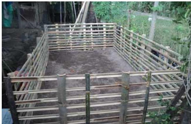
Gambar 3 Kerangka bak terpal yang sudah jadi
