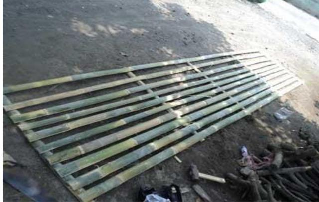
Gambar 2 Kerangka bambu bagian dinding bak terpal
