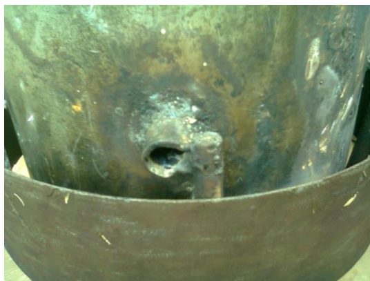
Gambar 9. Saluran udara dan pengatur bukaan udara
