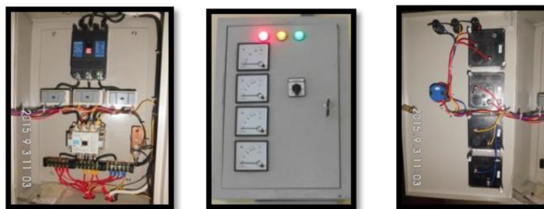
Gambar 3. Realisasi sistem instrumentasi turup luar dan dalam panel box kontrol
