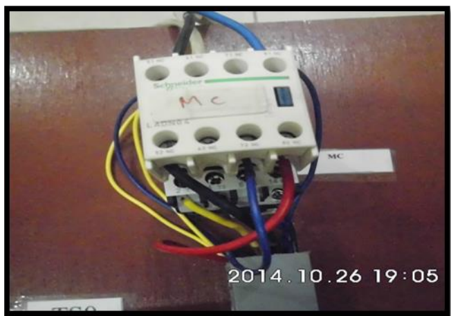
Gambar 4. Main contactor (kontaktor utama)
