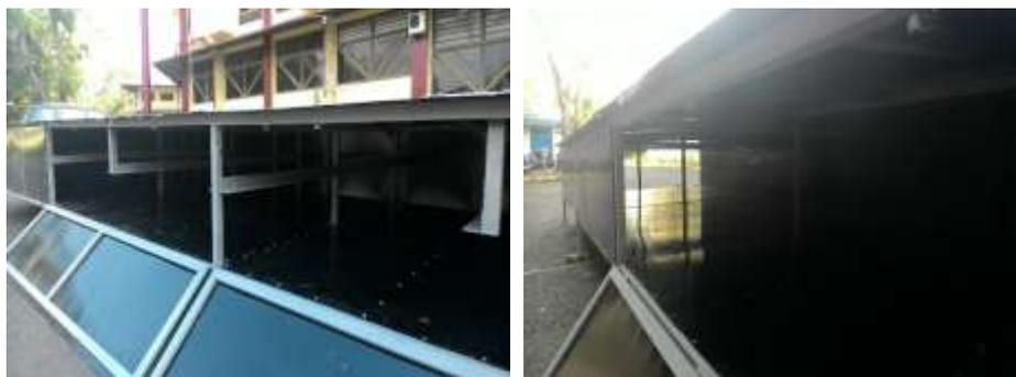
Gambar 5. Tempat rak pengering dan lorong udara pada alat pengering tenaga tenaga surya dengan kolektor pelat datar dan turbin ventilator
