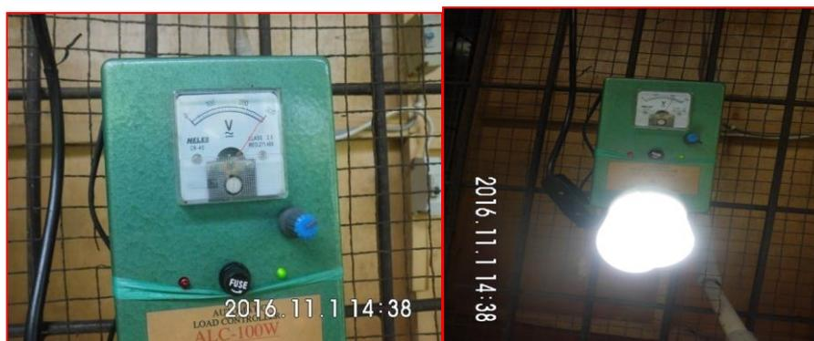
Gambar 11. Tegangan *output* pada generator sebesar  $\pm 300$  volt tanpa beban dengan bukaan 100% dan tegangan setelah terbebani sebesar  $\pm 220$  volt dan lampu terlihat terang.
