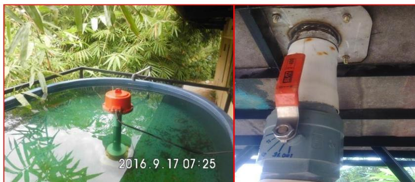
Gambar 8. Kondisi bak penenang (tetap penuh) dan posisi bukaan stop kran 75%
