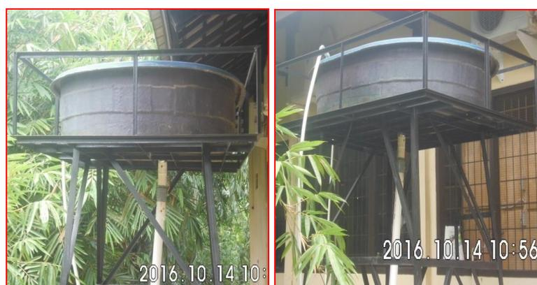
Gambar 2. Konstruksi penempatan bak penenang (forebay)
