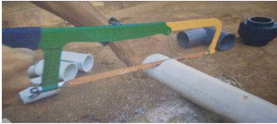
Gambar 2. Tahap Pemotongan pipa
