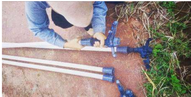
Gambar 5. Pemasangan sprinkler di riser.
