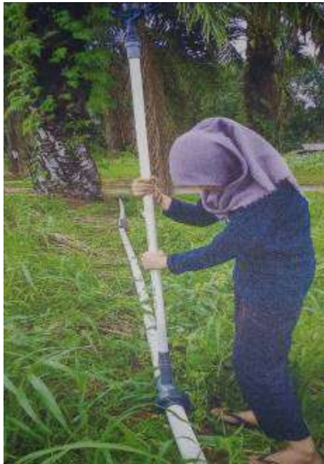
Gambar 6. Menyambungkan riser dengan pipa lateral
