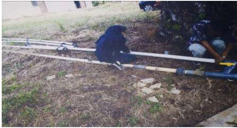
Gambar 4. Proses penyambungan pipa lateral dengan kran stop.
