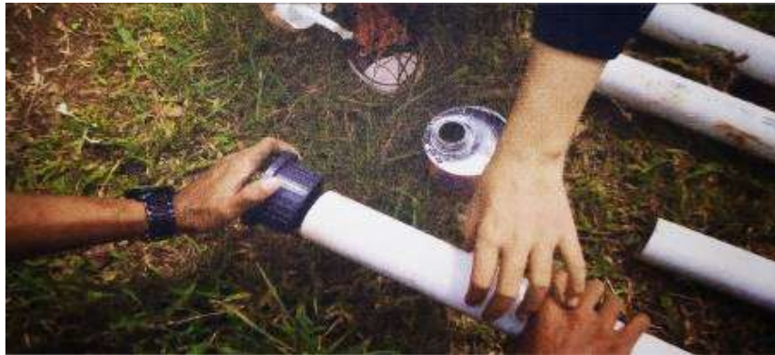
Gambar 3. Tahap pengeleman pipa
