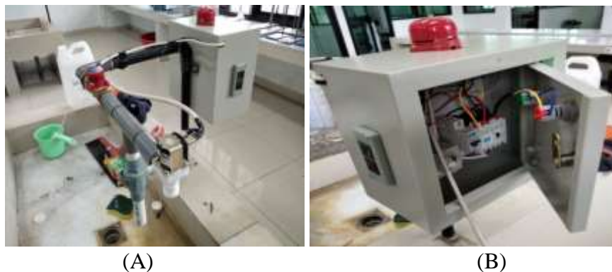
Gambar 12 pengujian sistem Proteksi pada Destilator Tipe Favorite W4L. (A dan B) ketika aliran air pada water inlet mati sehingga destilator juga mati.
