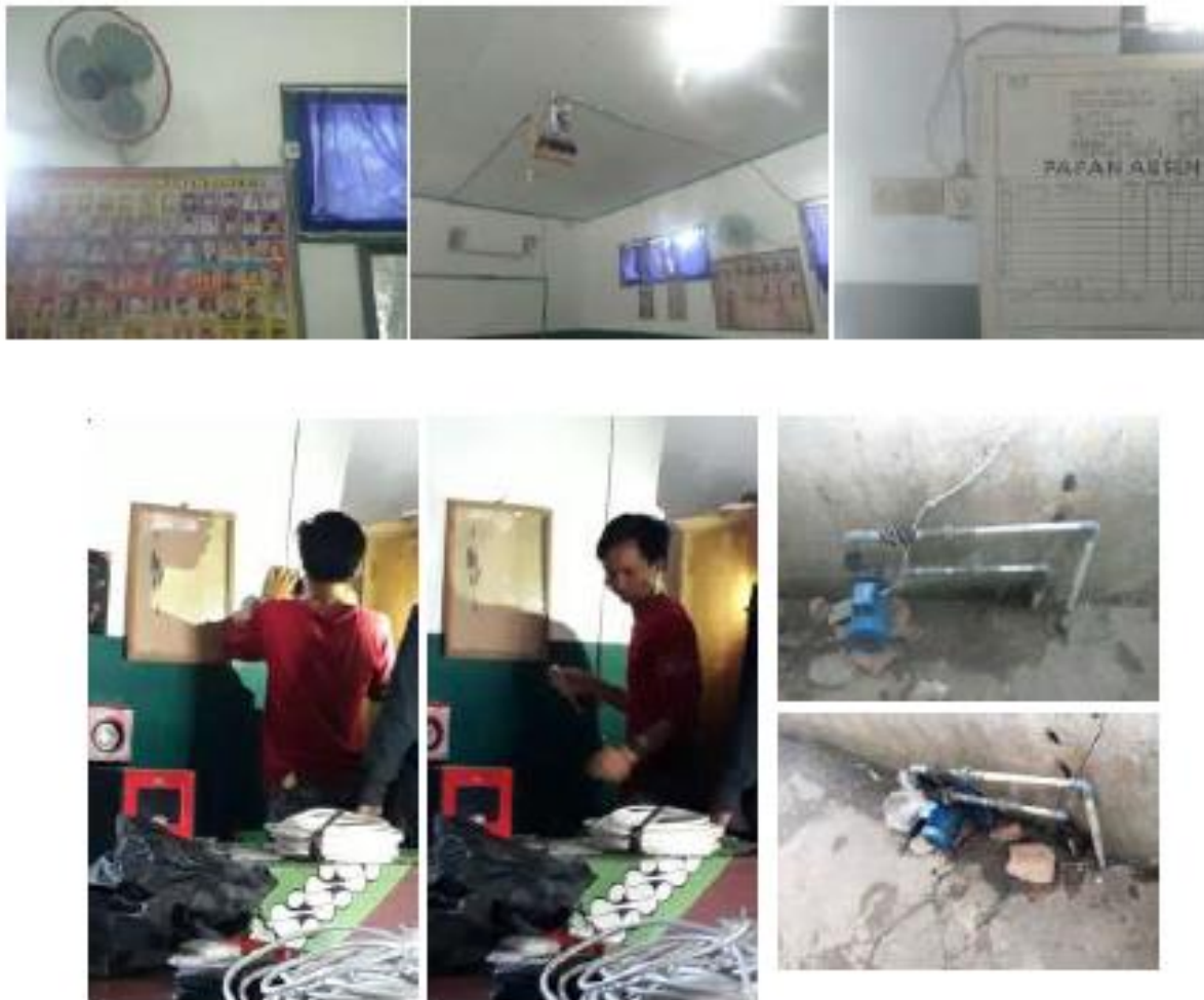
Gambar 6. Perbaikan Instalasi Listrik
