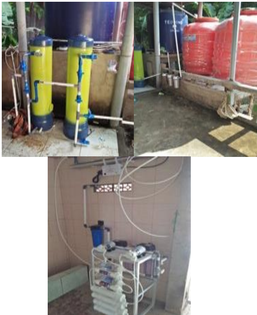
Gambar 1. teknologi membran Reverse Osmosis dan sinar Ultraviolet
