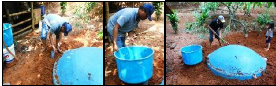
Gambar 5. Proses perakitan bak pencampuran bahan
