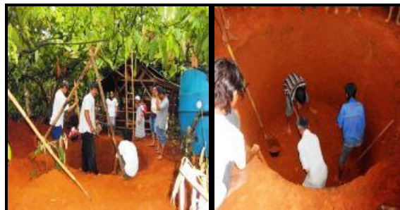
Gambar 3. Penempatan dan penggalian untuk reaktor
