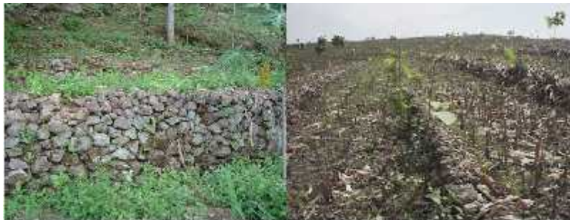
Gambar 6. Teras bangku dengan tampungan dari batu dan guludan dari batu
