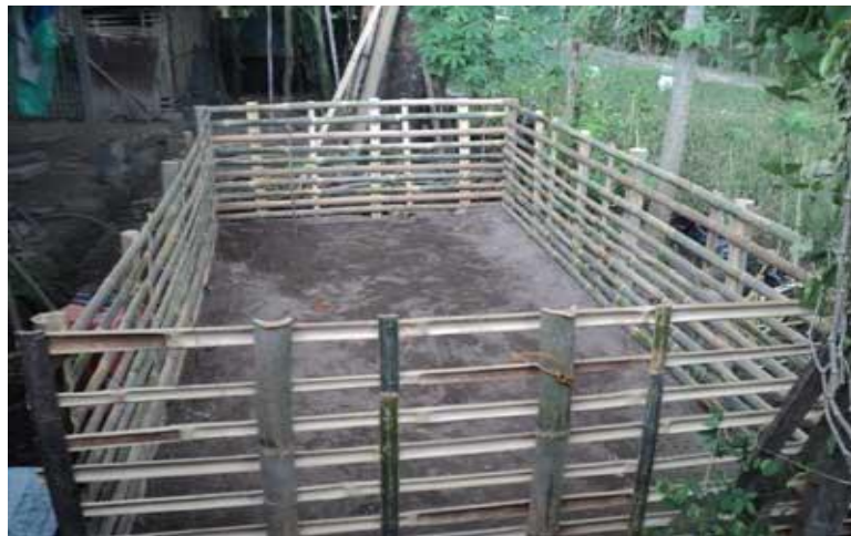
Gambar 3. Pemasangan pagar dinding bak dengan patok bambu
