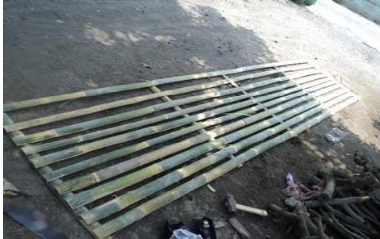
Gambar 2. Proses Pembuatan Pagar Bambu
